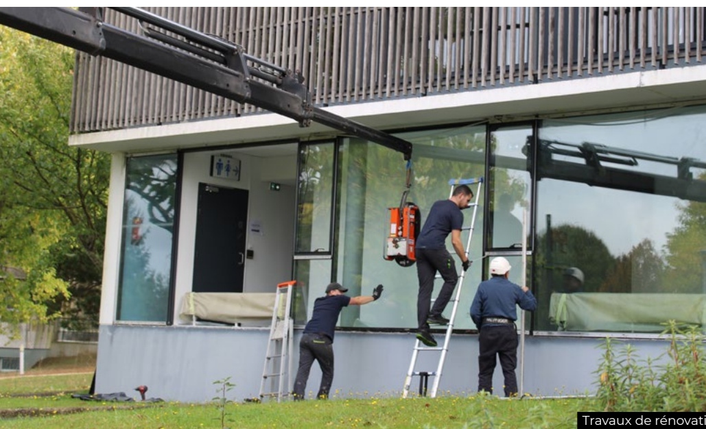
Travaux de rénovation énergétique d'une partie des bâtiments.
